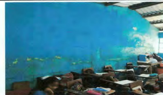
Foto 6: Aplicación de impermeabilizante en paredes en aulas del módulo 5 por exceso de humedad.
