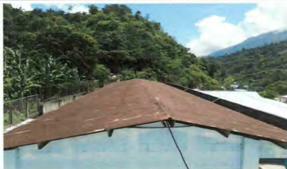
Foto 1: Sustrucción de láminas de zinc que se encuentran oxidadas por láminas de troqueladas calibre 26.
