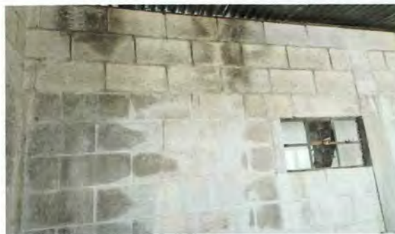
Foto 4: Mantenimiento de paredes con repello interior del aula del módulo 6 para mejorar las condiciones del espacio.
